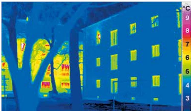
Diese Thermografie zeigt den Unterschied zwischen einem sanierten und einem unsanierten Gebäude sehr deutlich: Ungedämmte, wärmere Außenwände werden durch die gelbe bis rote Farbe gekennzeichnet, kühlere Gebäudeteile sind blau.
