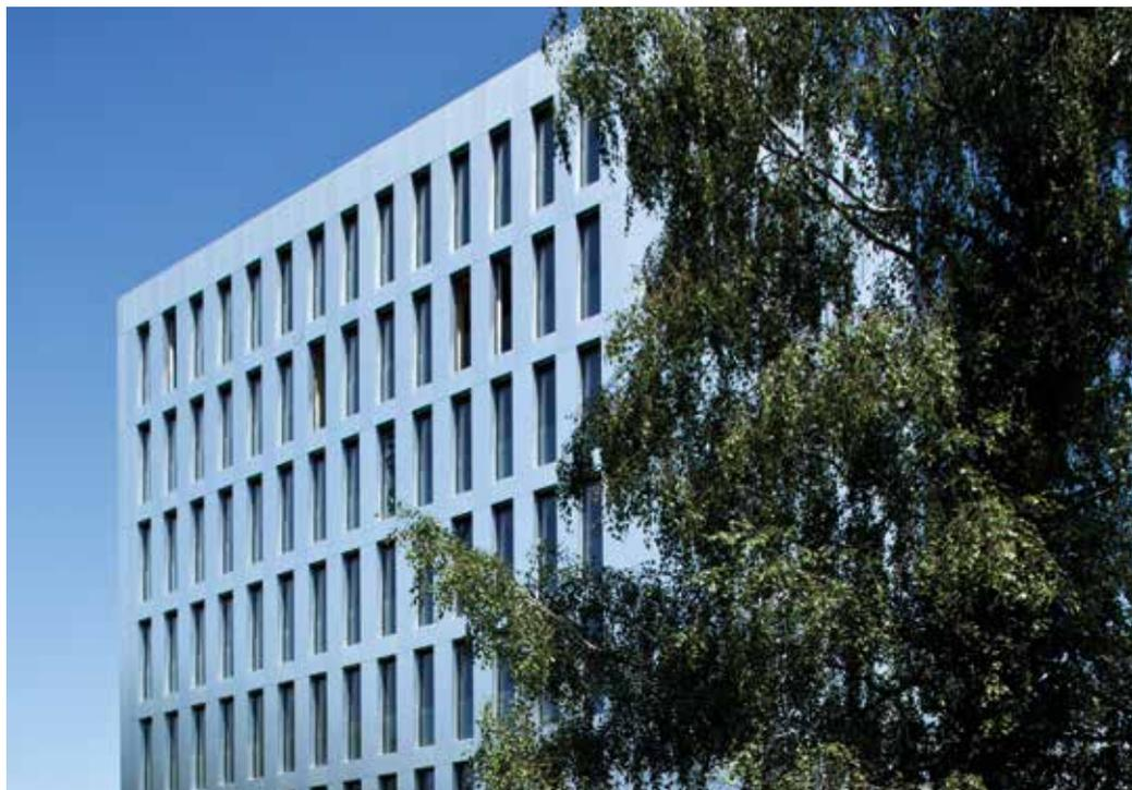
Der so genannte LifeCycle Tower ist ein nachhaltiges, modulares Holz-Hybrid-Gebäudesystem für großvolumige Gebäude mit bis zu 30 Stockwerken.
